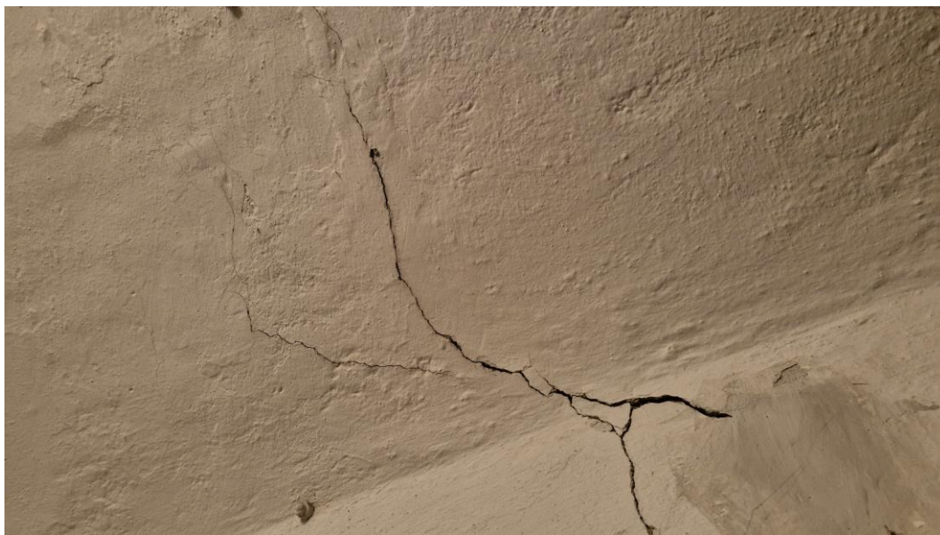
Pokračování trhliny do klenby, valené do klenebního pásu
