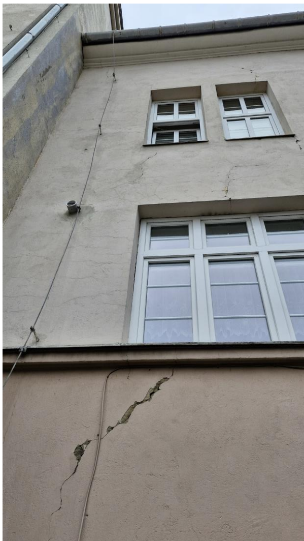
Trhliny v nosných stěnách – dvorní trakt v rohu
