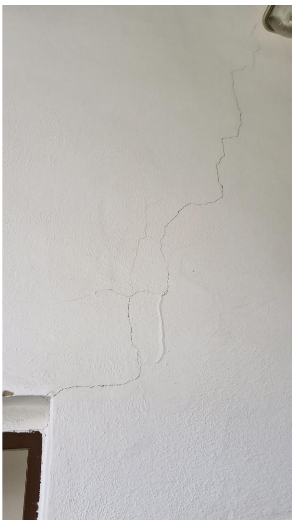
Trhliny v přilehlých nosných zdech v zázemí kuchyně
