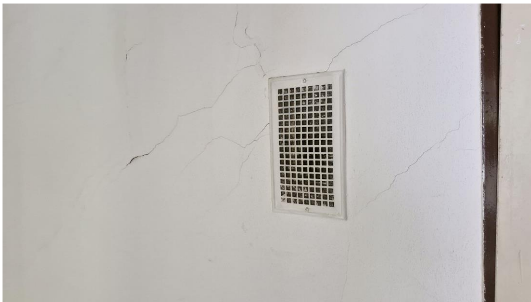
Trhliny v přilehlých nosných zdech v zázemí kuchyně
